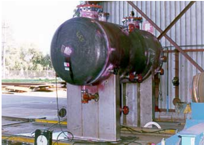
شکل ۴-۵ انجام تست هیدرواستاتیک روی یک مخزن تحت فشار
